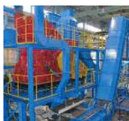
金属破碎・選別設備
