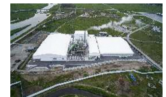
浪江町 仮設焼却施設
