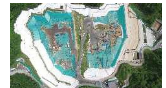
特定廃棄物埋立処分場
