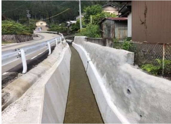
高畑谷集落排水路
