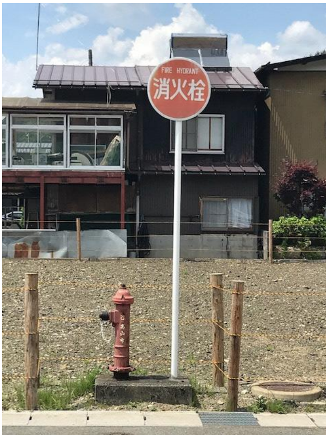
物件南側を撮影（高山市の消火栓があります。）
