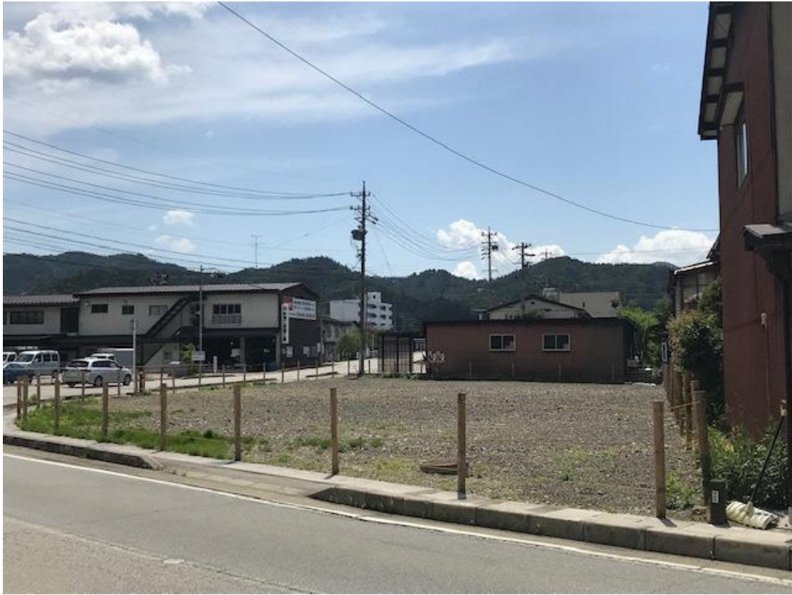
物件東方向から西方向を撮影
