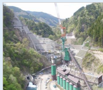
内ヶ谷ダム建設工事
