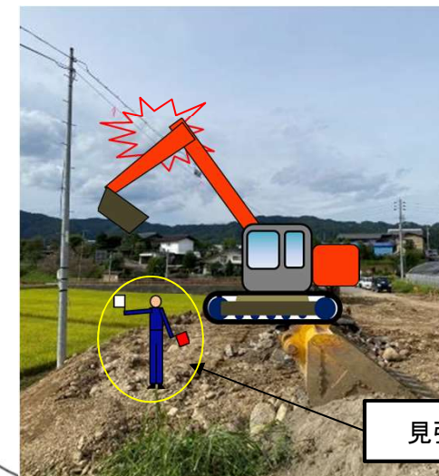
事故現場状況写真
