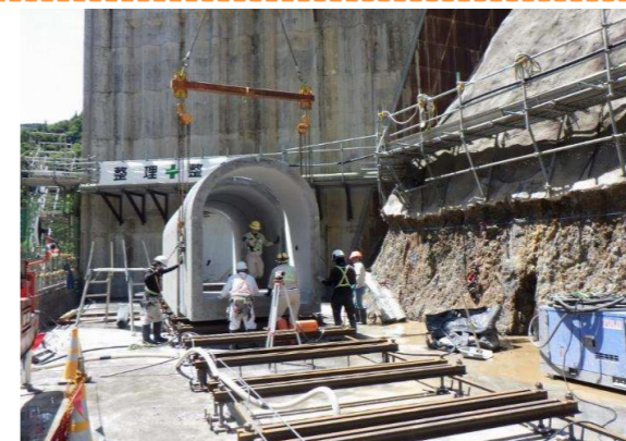
監査廊設置状況
