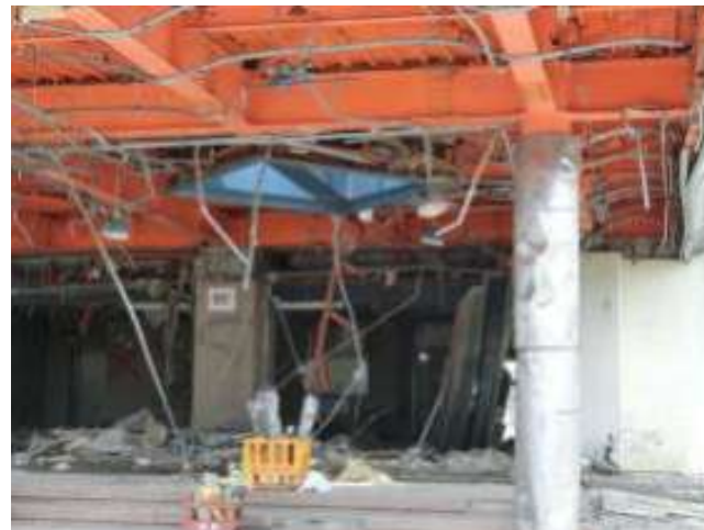
岩手県陸前高田市役所の被害状況
