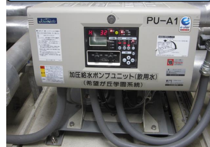
センターに飲料水を供給する給水ポンプ（給水ポンプ室）
