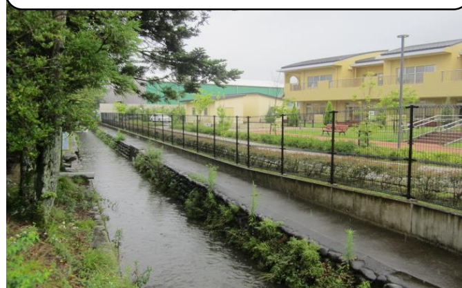
令和2年7月8日降雨時の早田川増水状況（センター南）
