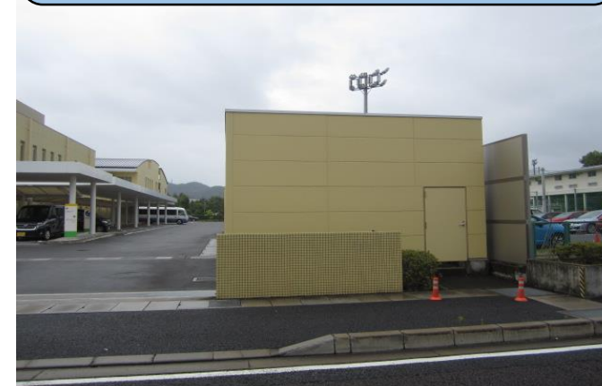
受水槽・給水ポンプ室のある建物（センター北西の角）
