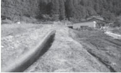
用水路の整備 (郡上市)
