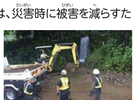
線路へ流出した土砂の除去
