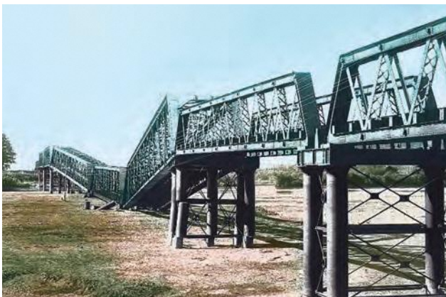
長良川鉄橋（岐阜－穂積）崩落 原画提供：岐阜県歴史資料館
