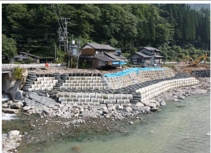
応急工事完了後
