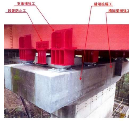
P2橋脚-P1側
