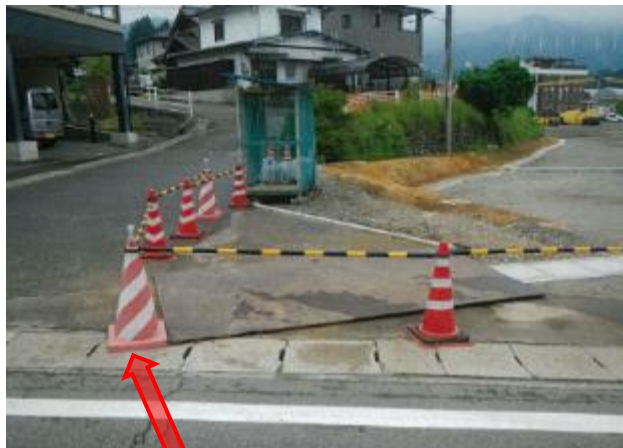
作業終了時(前日)の状況
