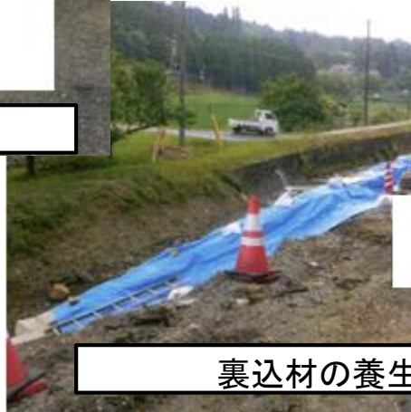
仮置き再生砕石の養生
