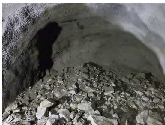
吹付けコンクリート施工完了状況
