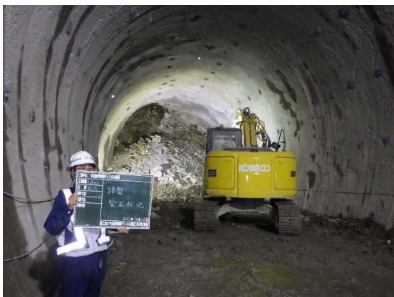
路盤整正状況
