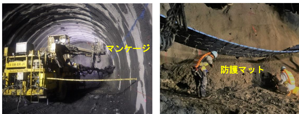
図 6-1 設備的防護対策の例
