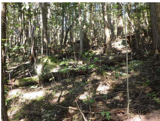
肌落ち箇所付近の地表面確認状況
