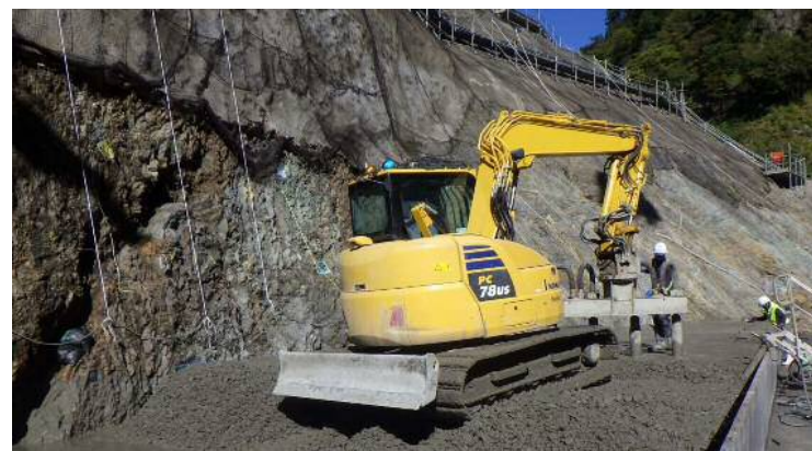
バックホウのバイブレータによる締固め状況
