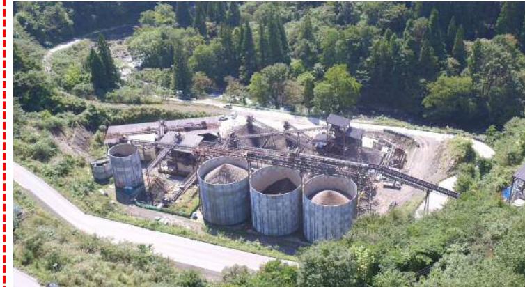
⑤ 骨材製造設備稼働状況
