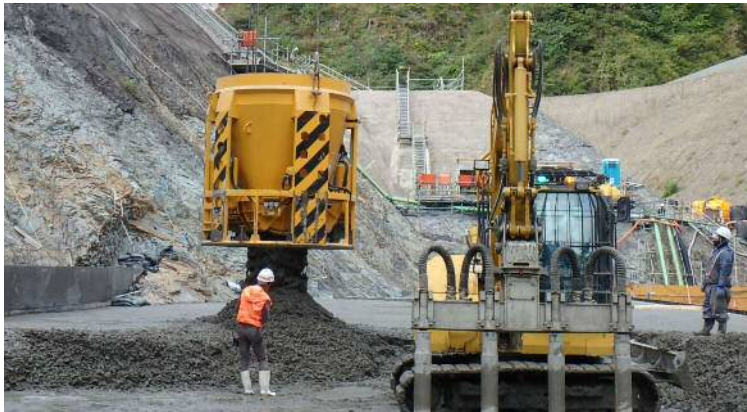
バケットによるコンクリート打設状況
