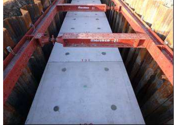
ボックスカルバート布設状況
