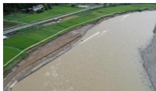
③ 飛騨川／護岸損壊 (高山市久々野町)
