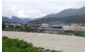
⑤ 国道41号／路側欠壊 (下呂市萩原町花池)
