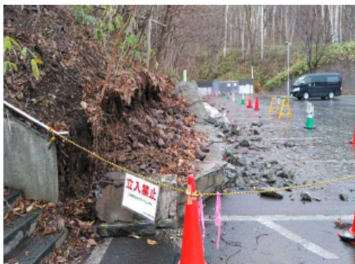
事故発生状況
