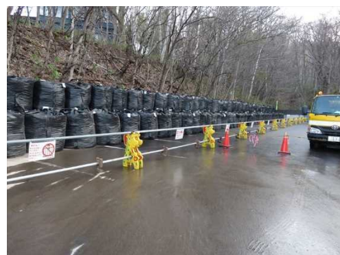
応急復旧完了
