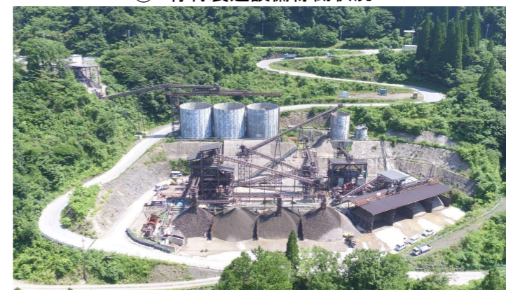
⑦ 骨材製造設備稼働状況
