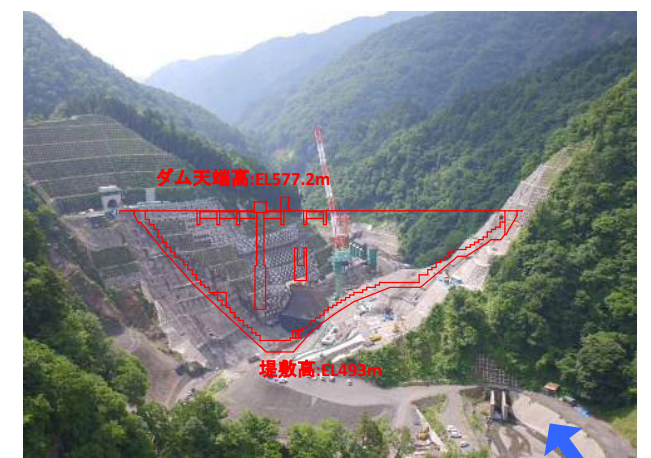
④ ダムサイト状況(上流上空より望む)
