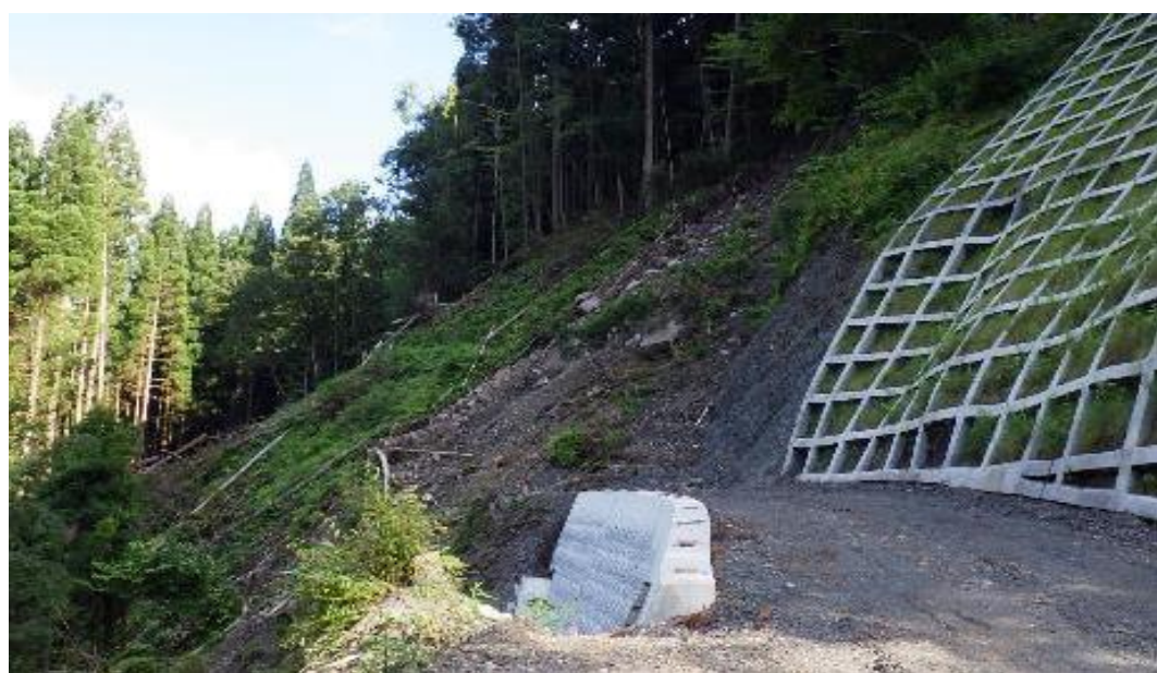
⑤ 下流工事用道路状況
