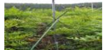
スプリンクラー設置
