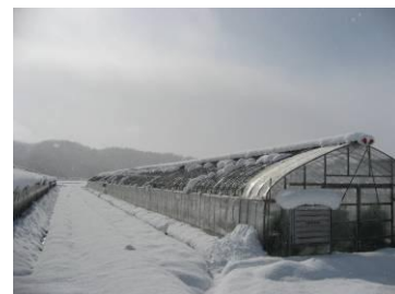
【屋根のビニールを巻き上げて倒壊を回避】
