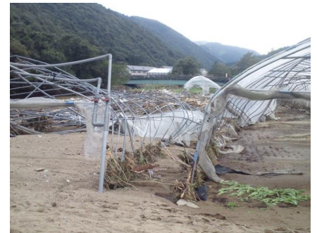
【倒壊したハウス（高山市）】
