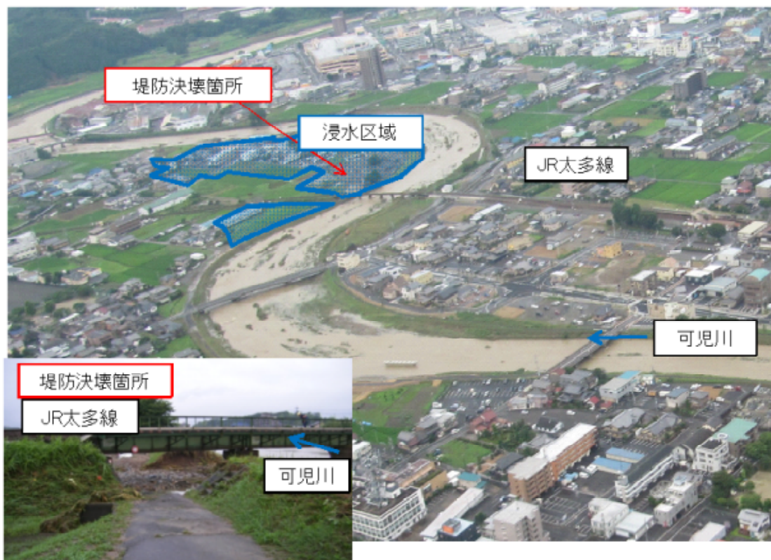
可児市広見の浸水被害状況
