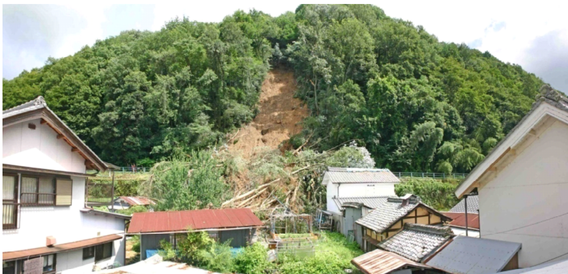
可児市兼山盛住の土砂災害被害の状況
