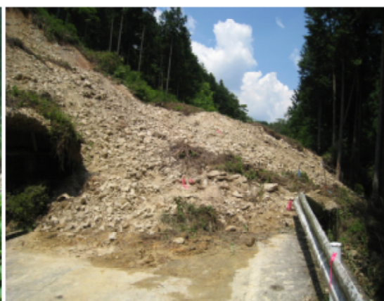
農道法面が崩落（東白川村神土）
