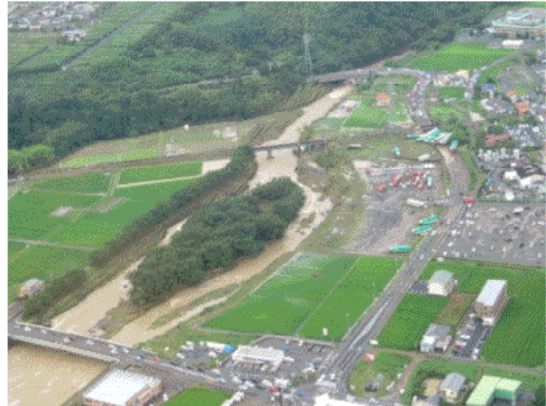
可児市土田 可児川氾濫状況 7月16日撮影
