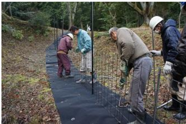
鳥獣防護柵設置状況
