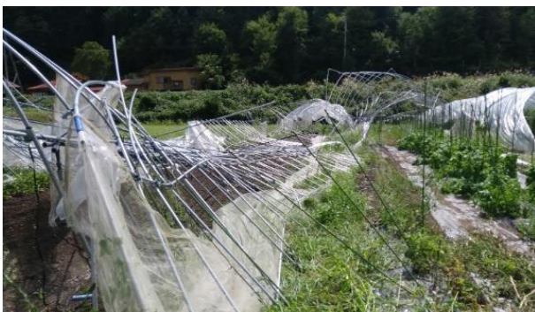
風水害によるパイプハウスの倒壊
