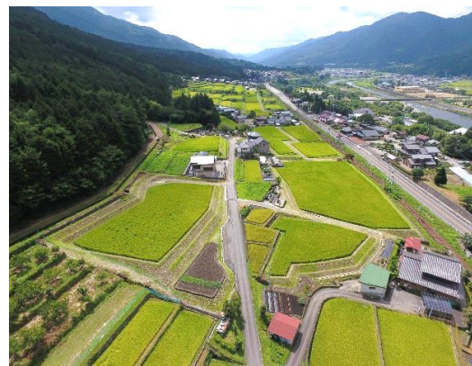
中山間地域におけるほ場整備 (下呂市 益田北東部地区 大町団地)
