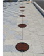
汲み取り処理方式 マンホールトイレ
