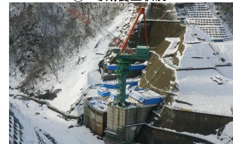
⑦ 冬期養生状況
