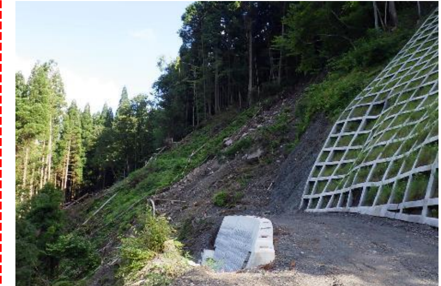
⑤ 下流工事用道路状況
