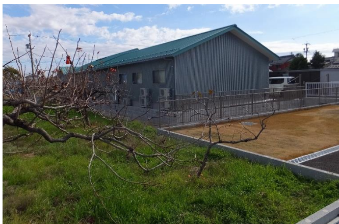
施設外観(北西角から)
