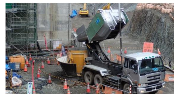
練り混ぜて出来上がったコンクリートをクレーンへと受け渡すため、ベッセルダンプというコンクリート運搬用の特殊なダンプにて、コンクリートプラントからクレーンに設置したバケットまで運搬しています。
