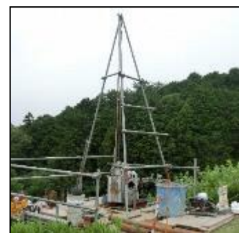
ボーリング調査
