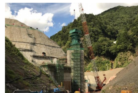
⑦ タワークレーン施工状況
