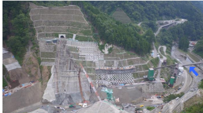
③ ダムサイト左岸状況(右岸上空より望む)
