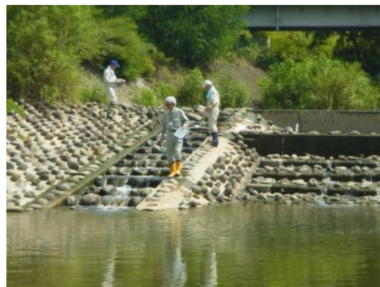
図-4.10 FWSによる魚道点検実施
