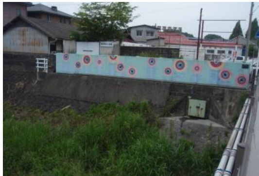
図-2.10 御幸橋陸閘（全景）
