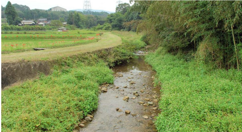
図-4.5 土岐川での改修事例－2
