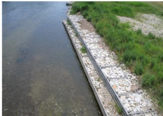
図-4.6 木工沈床の整備
