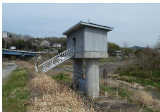
図-2.8 前の川逆水樋門（全景）
