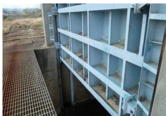
図-2.9 前の川逆水樋門（扉体）
