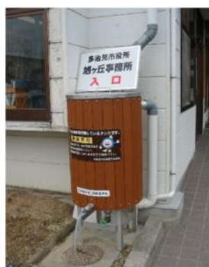
図-4.8 貯留・浸透施設の設置
