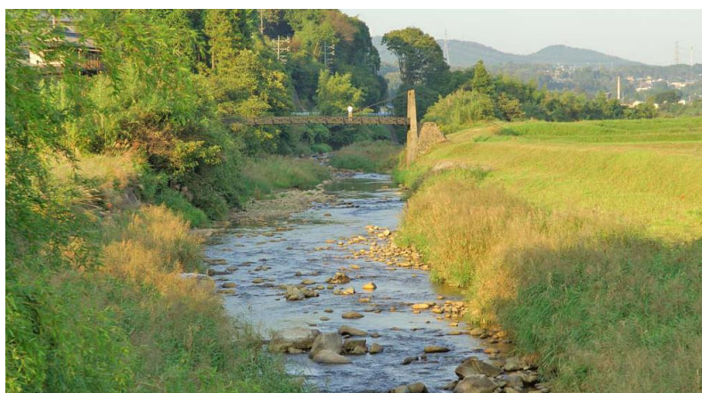
図-4.4 土岐川での改修事例－1
