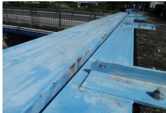
図-2.11 御幸橋陸閘（扉体）
