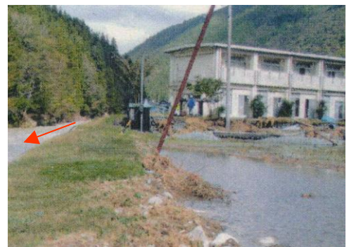
H16 馬瀬川(下呂市) 浸水状況
