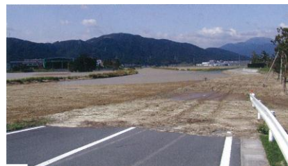
泥川 養老町室原 (泥川橋より上流)
