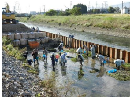
工事中の生物保護活動（杭瀬川）
