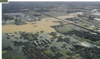
大谷川右岸地区の浸水状況
