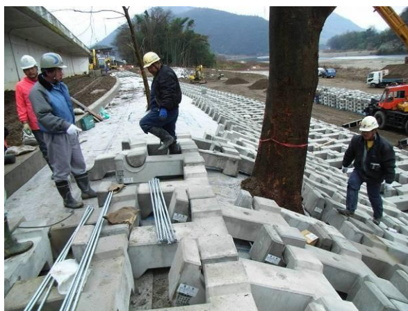
高木を保全する護岸工法の試行
