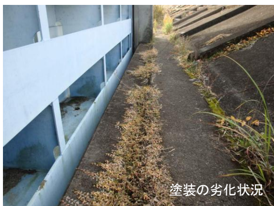
図-2.19 河川構造物の老朽化の事例
