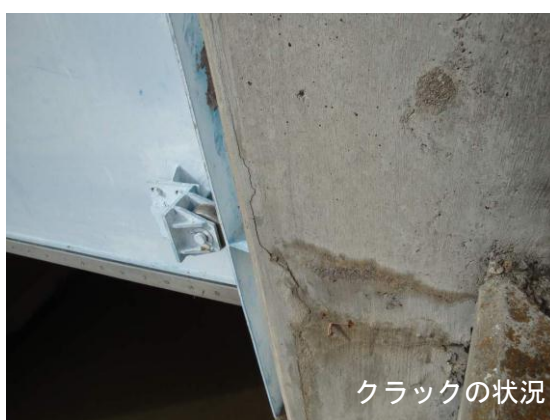
図-2.19 河川構造物の老朽化の事例
