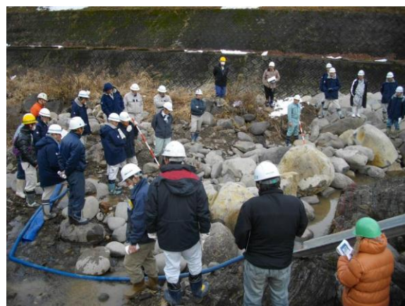
図-4.10 自然共生川づくり（分散型落差工）（長良川・郡上市大和町）
