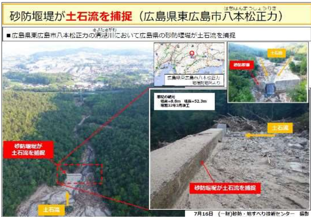
※国土交通省砂防部ホームページより 平成30年7月豪雨 清瀧川（広島県東広島市八本松正力地内）の捕捉事例
