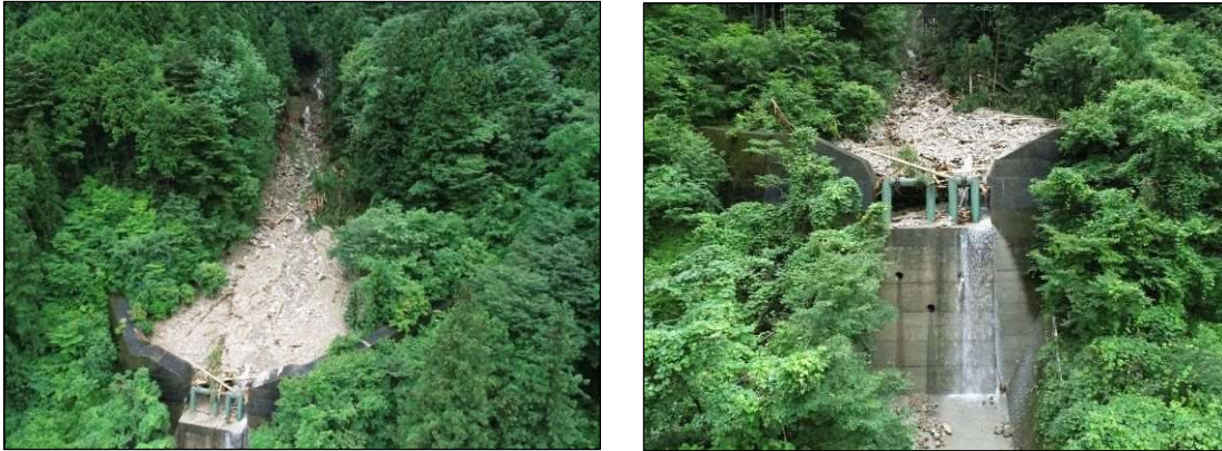
クラ平谷（下呂市小坂町地内）の捕捉事例
