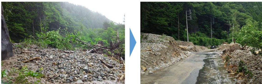
国道471号 高山市上宝町葛山地内の道路啓開状況
