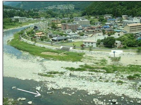
令和元年6月完成
