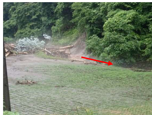
生井川 流木堆積状況 (高山市岩滝地内)
