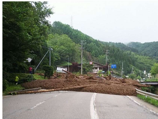
高山市丹生川町久手 国道158号 土砂流出状況
