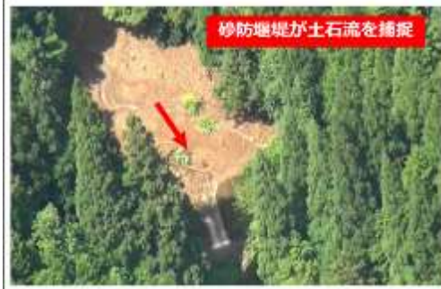
土石流の捕捉状況 （国土交通省砂防部HPより）
