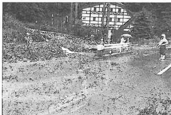
緊急に対策が必要な箇所（国道、発電所）
