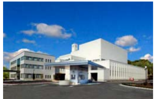
一般廃棄物処理施設 多治見市 三の倉センター
