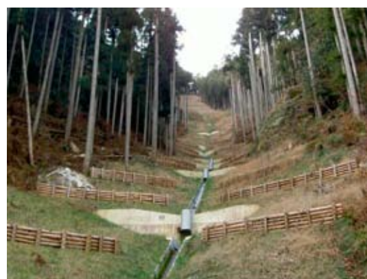
治山工事による復旧
