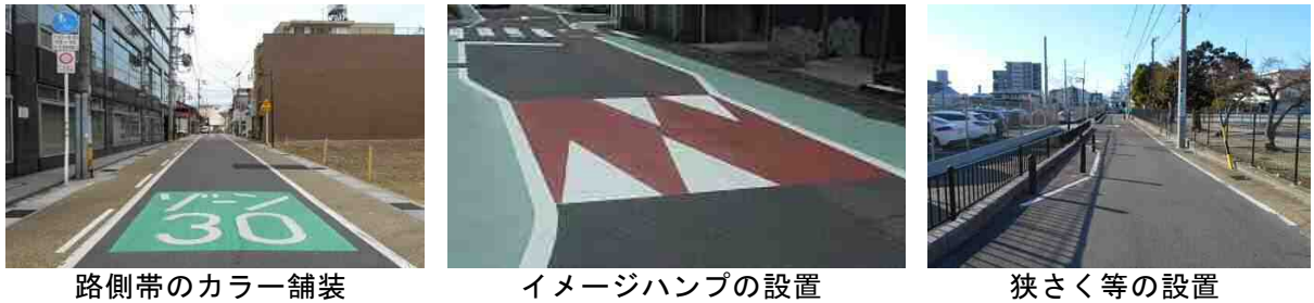
図表4-7 ゾーン内における速度抑制対策の例
