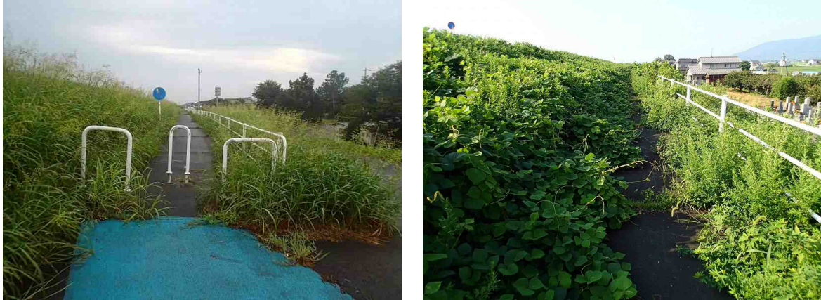
図表4-4 長良川自転車道における雑草の繁茂状況
