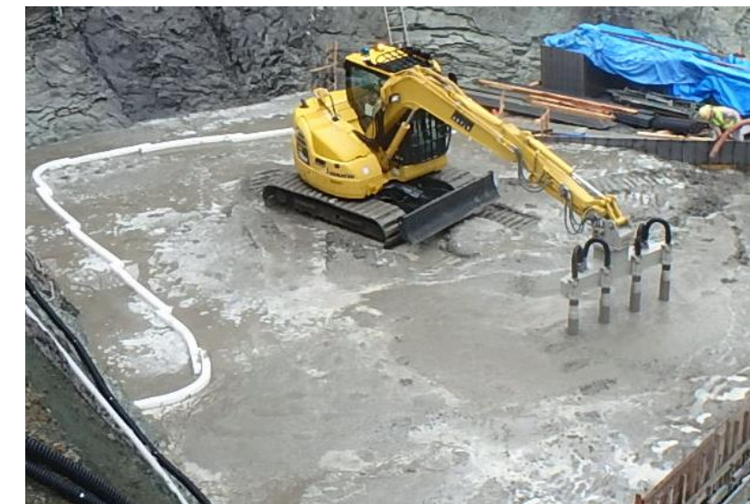
⑥ コンクリート締固め状況
