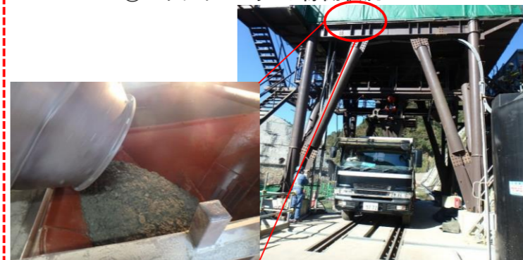
⑦ バッチャープラント稼働状況
