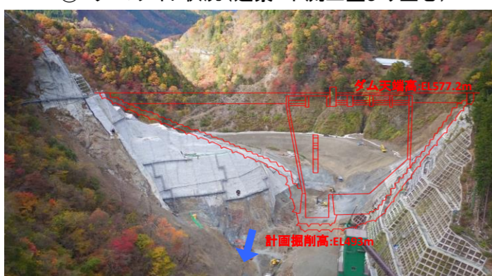
② ダムサイト状況(近景:下流上空より望む)
