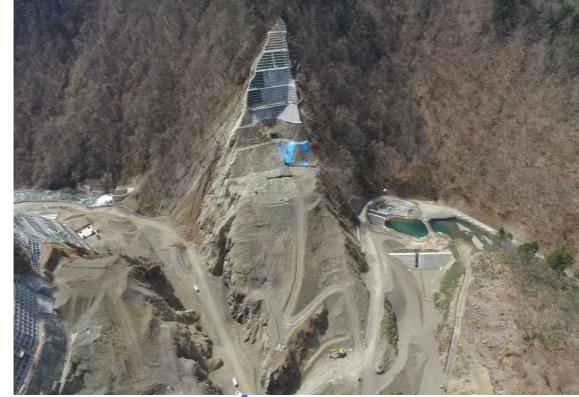
④ ダムサイト状況(左岸上空より望む)
