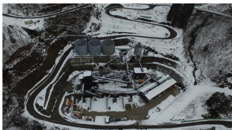
⑥ 骨材プラント状況(上空より望む)
