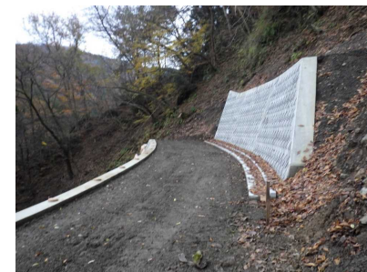
⑤ 下流工事用道路状況
