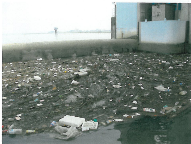
(堰上流部に滞留した流木・塵芥)
